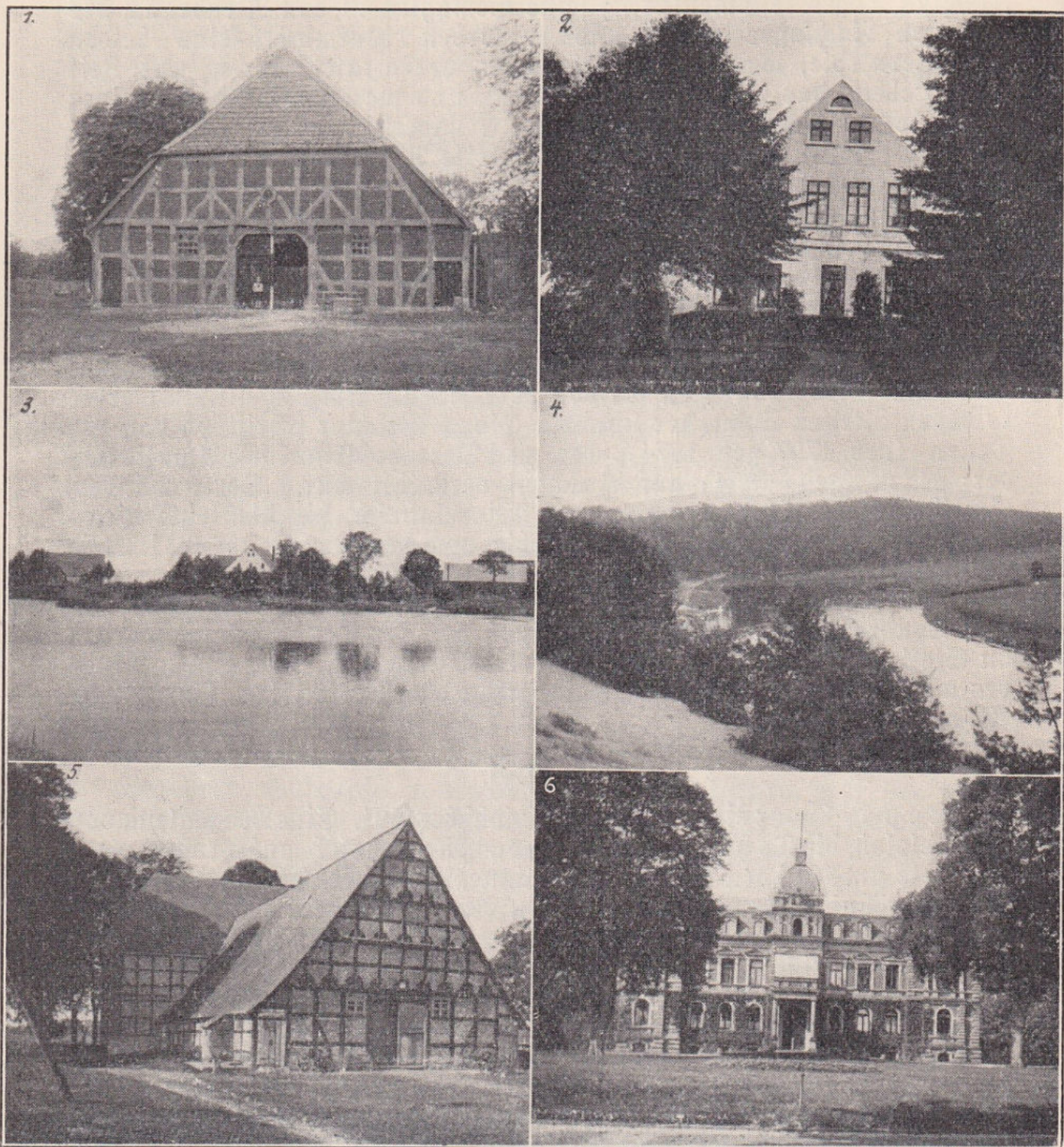
1. Das Wirtschaftsgebäude des Lesseler Gutshauses von 1691. 2. Das 1840 erbaute Gutshaus in Wiepelnbusch. 3. Historischer Burgplatz des Clüverschen Schlosses an der Alten Aller in Cluvenhagen. 4. Partie an der Alten Aller (Wirraha, Alte Weser) bei Cluvenhagen am Weißen Berge). 5. Das adelige Wohnhaus in Groß-Koppel. 6. Das Schloß des Grafen Reventlow in Etelsen.
