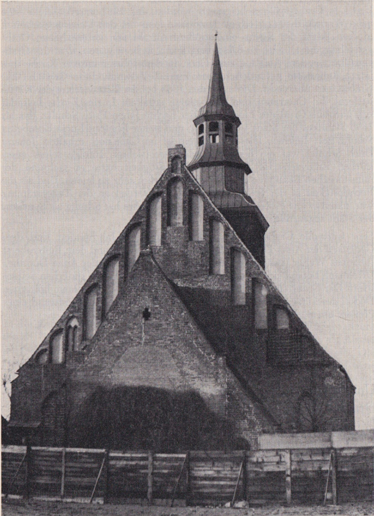
St. Johanniskirche von Osten gesehen (Blick durch die Baulücke Große Str. 21-25)
