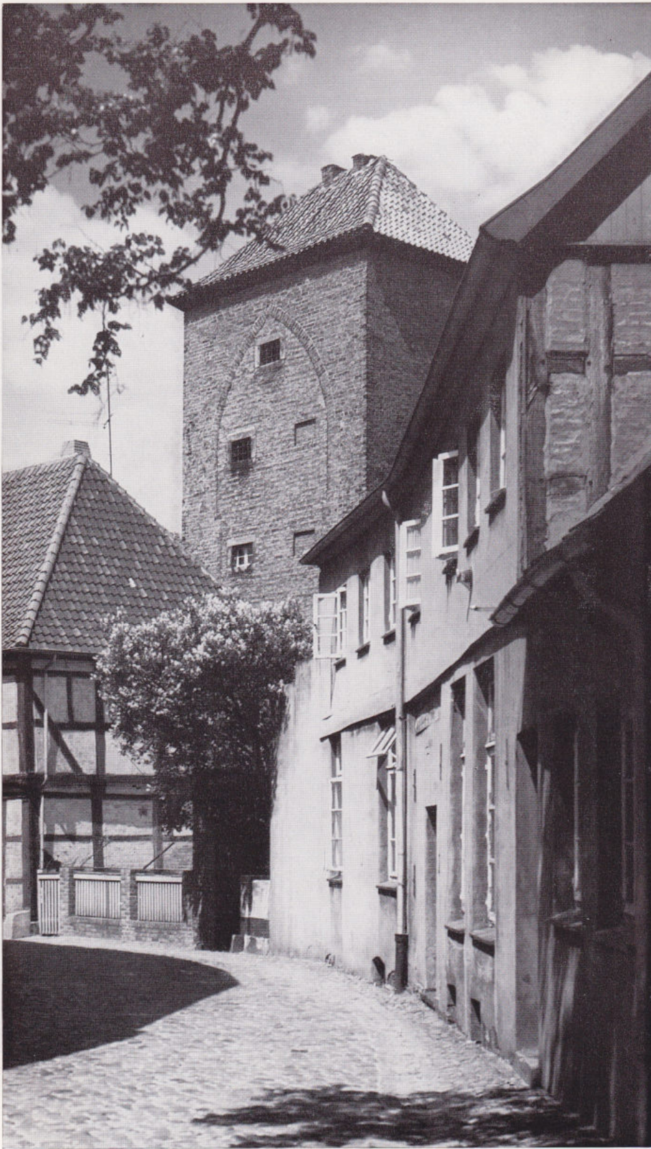
Der Piepenbrink ist ein Turm der alten Stadtbefestigung. Er zeigt nach der Wallseite noch Schießscharten und die Verbindung mit dem früheren Wehrgang.
