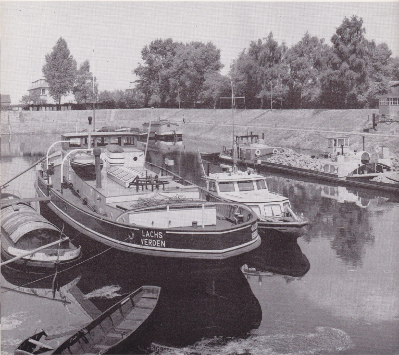
Der Schutzhafen und Bauhof des Wasser- und Schiffsamtes Verden.
