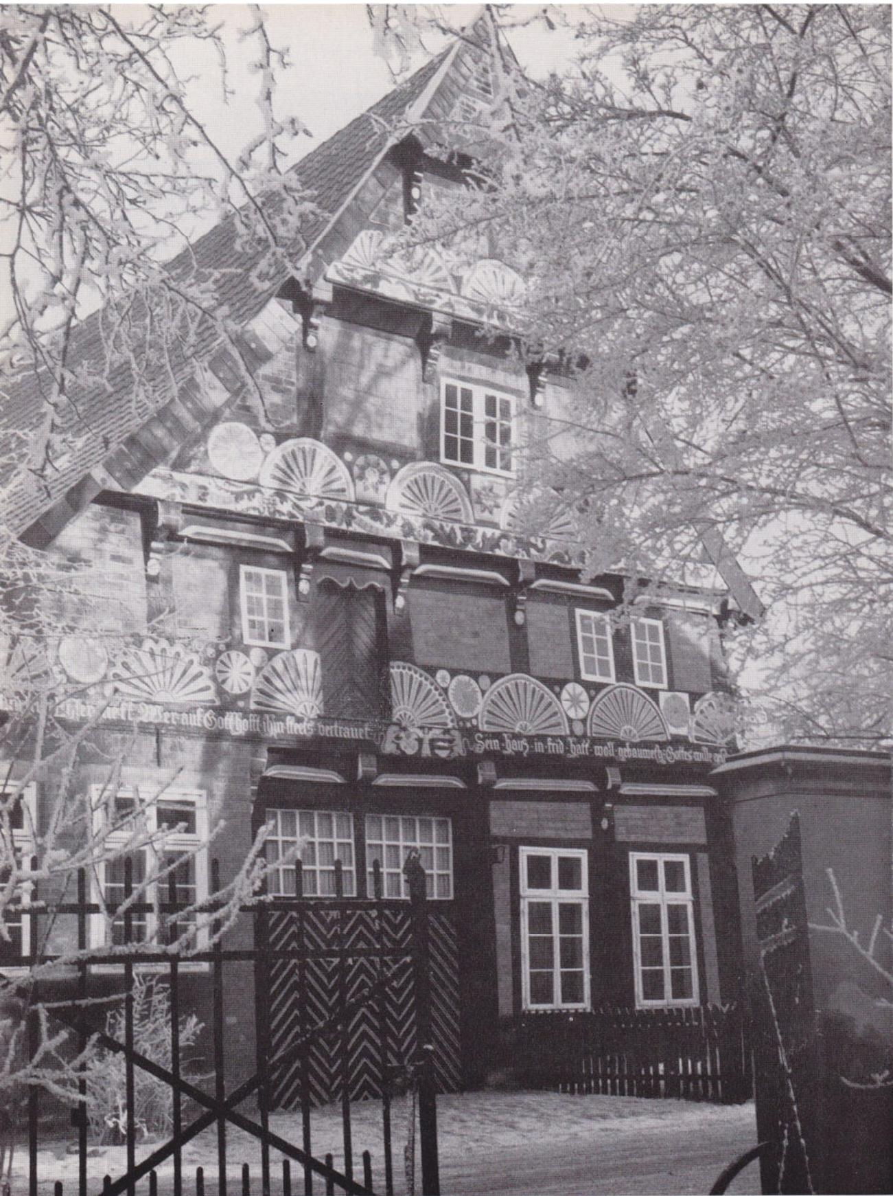
Das Haus Strukturstraße 7 ist ein aufwendiges Ackerbürgerhaus aus dem Jahre 1577 mit Windeluke und reichem Schnitzwerk.
