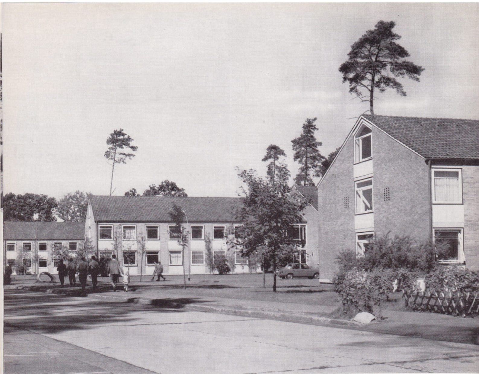
Mannschaftsunterkünfte der neuen Kasernenanlagen in Barmen im Kreise Verden.
